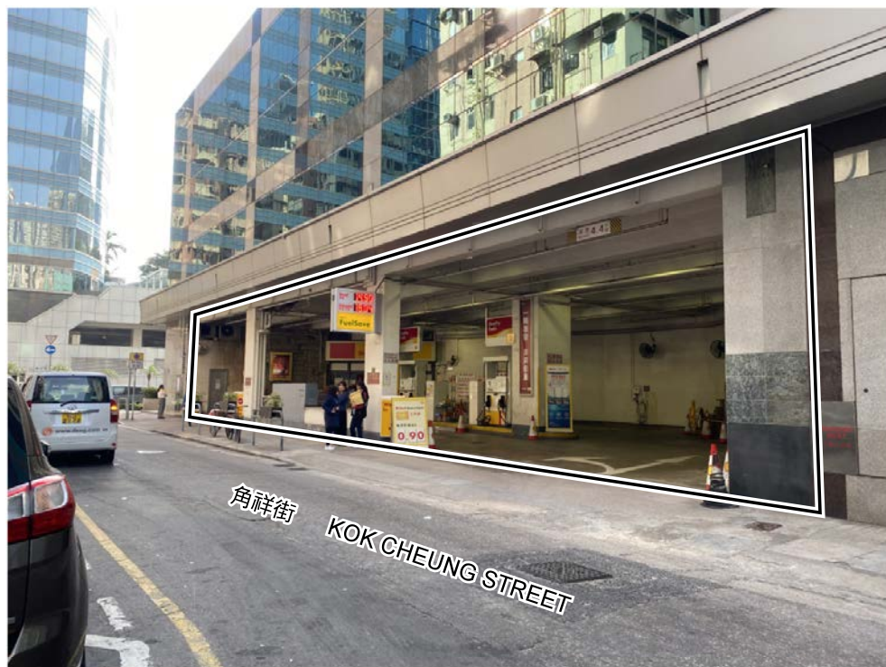
照片2 - 現有地下加油站 PHOTO 2 - EXISTING PETROL FILLING STATION ON G/F
