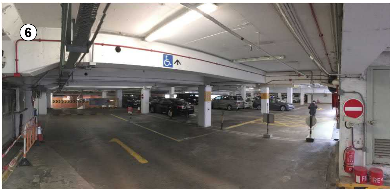
石硤尾邨停車場 CAR PARK IN SHEK KIP MEI ESTATE
