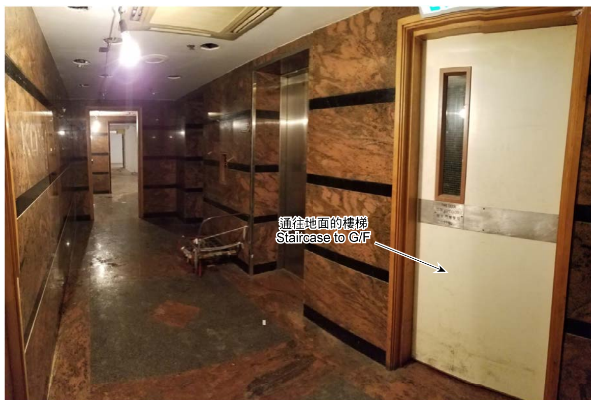
照片 2 — 電梯大堂 PHOTO 2 - LIFT LOBBY
