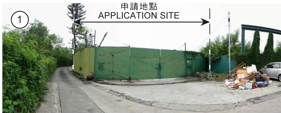
攝於2019年10月14日的實地照片 SITE PHOTO TAKEN ON 14.10.2019
