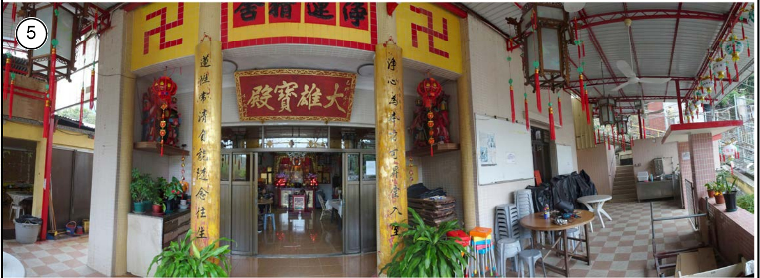
主廟宇(構築物 A) MAIN TEMPLE (STRUCTURE A)
