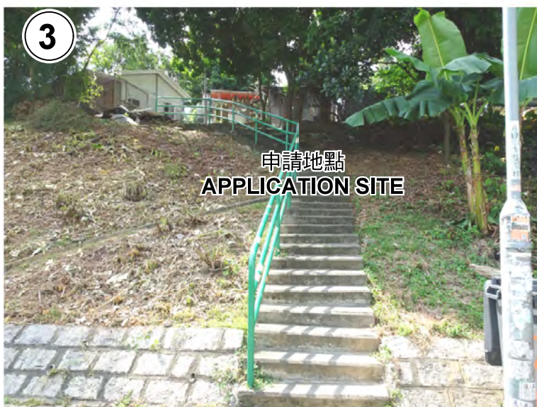
攝於2019年9月11日的實地照片SITE PHOTO TAKEN ON 11.9.2019
