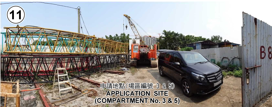
申請地點(場區編號 3 & 5) APPLICATION SITE (COMPARTMENT No. 3 & 5)
