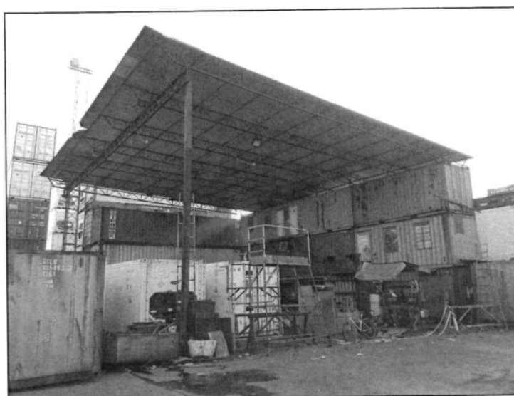
上蓋物 1 內有以貨櫃改建的臨時寫字樓，標示為 A。
