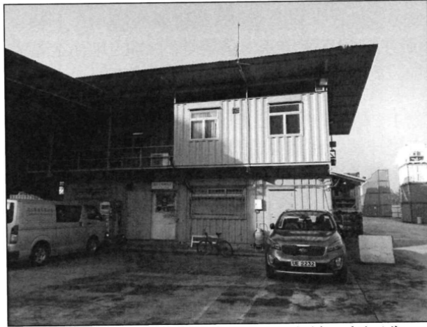
上蓋物2內有以一個以貨櫃併合改建的臨時寫字樓，標示為B。
