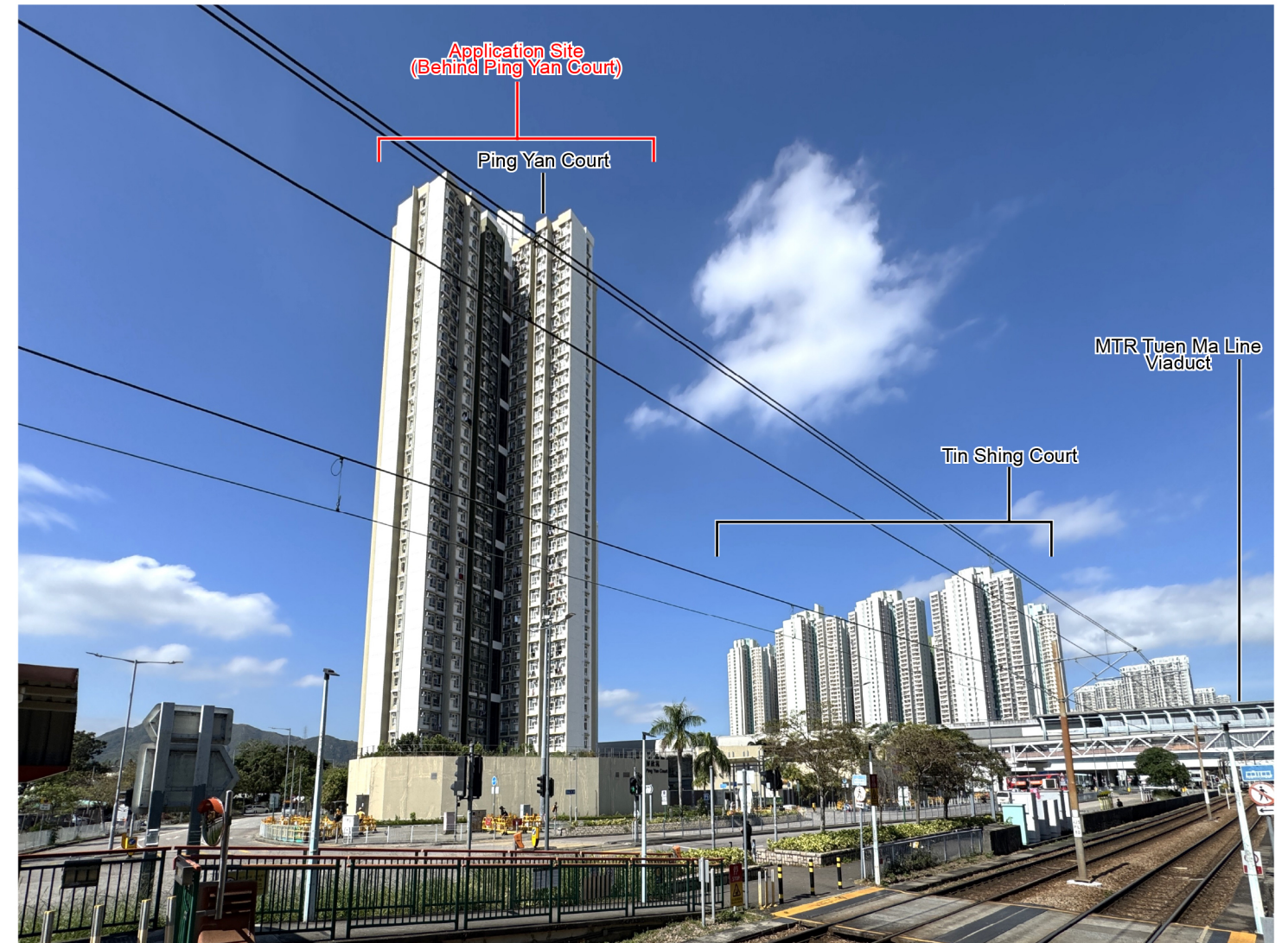
VP2: Hang Mei Tsuen Light Rail Station
