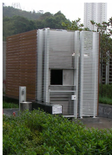
鑽石山火葬場
