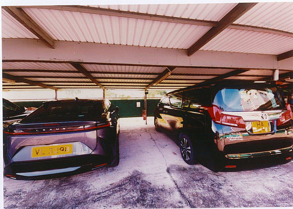
滅火筒和消防裝置及証書擺放位置
