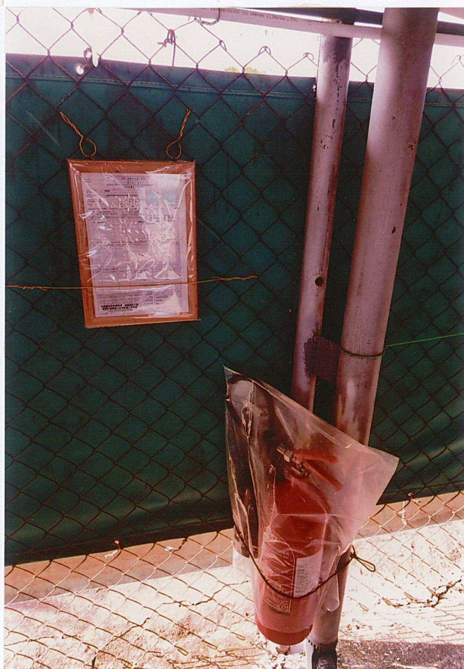
滅火筒和消防裝置及証書擺放位置
