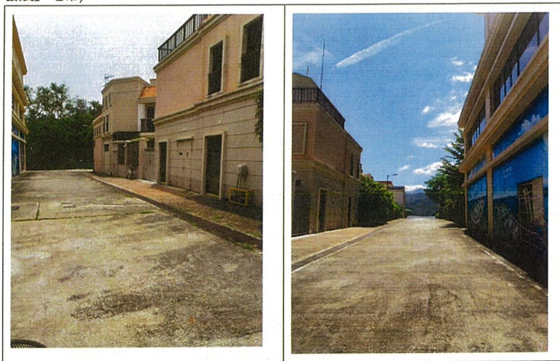
附圖7 坪利路「住宅(丙類)」土地用途地帶上分層住宅(有藍色圍板構築物位處「綜合發展」地帶)
