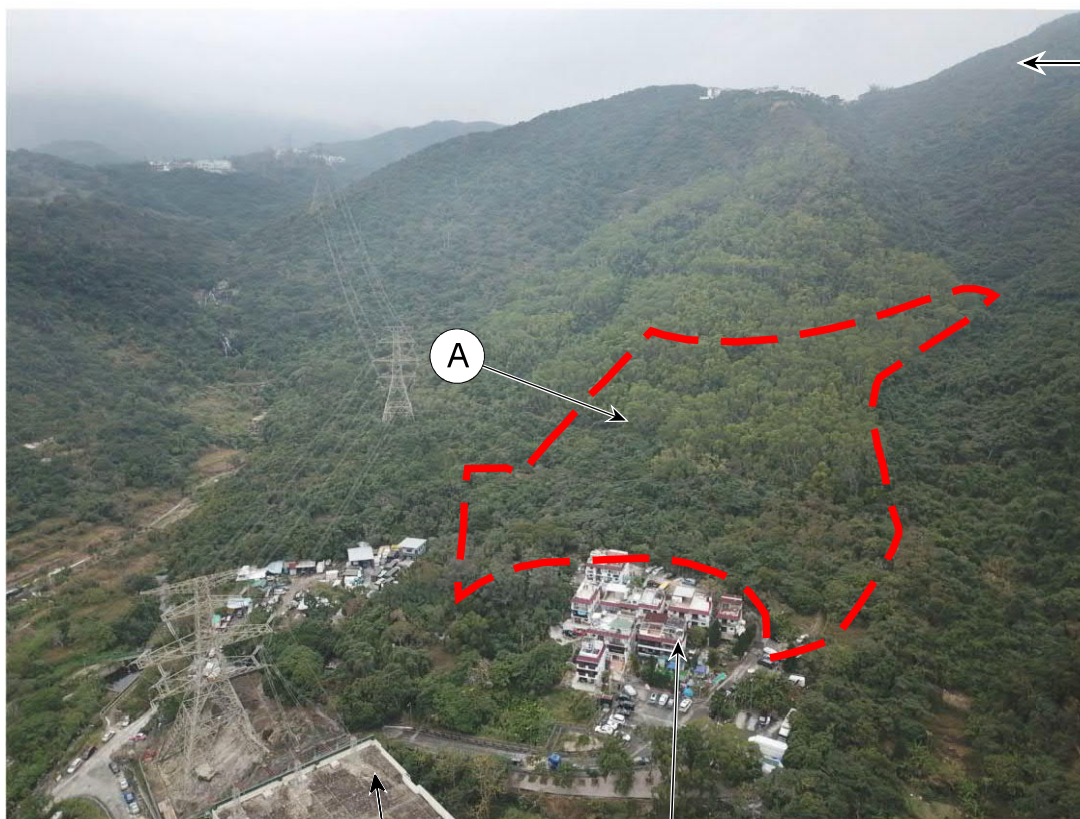
將軍澳400千伏變電站 TSEUNG KWAN O 400KV SUBSTATION
