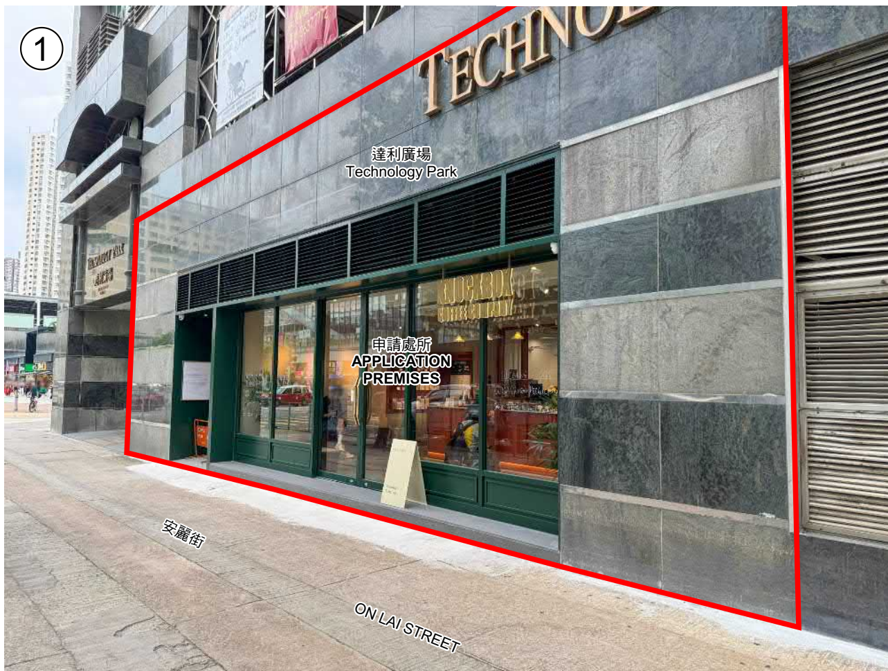
攝於2025年8月28日的實地照片 SITE PHOTO TAKEN ON 28.8.2025
