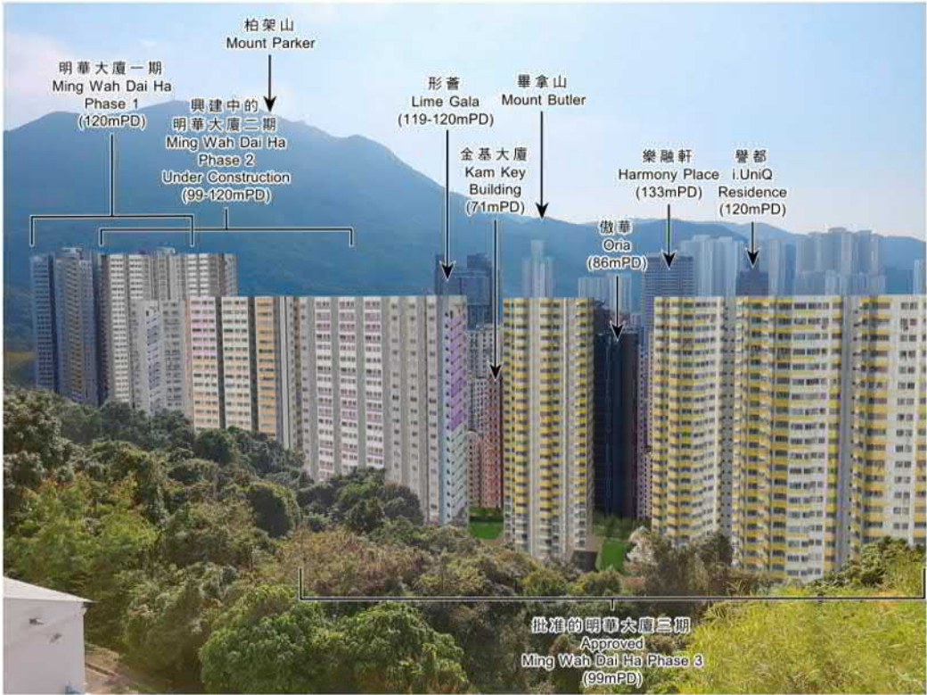
基線情況 BASELINE CONDITION
