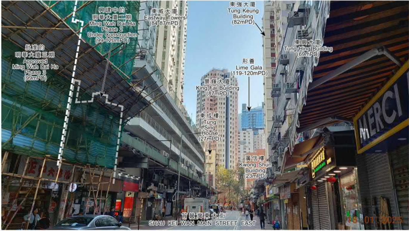
基線情況 BASELINE CONDITION
