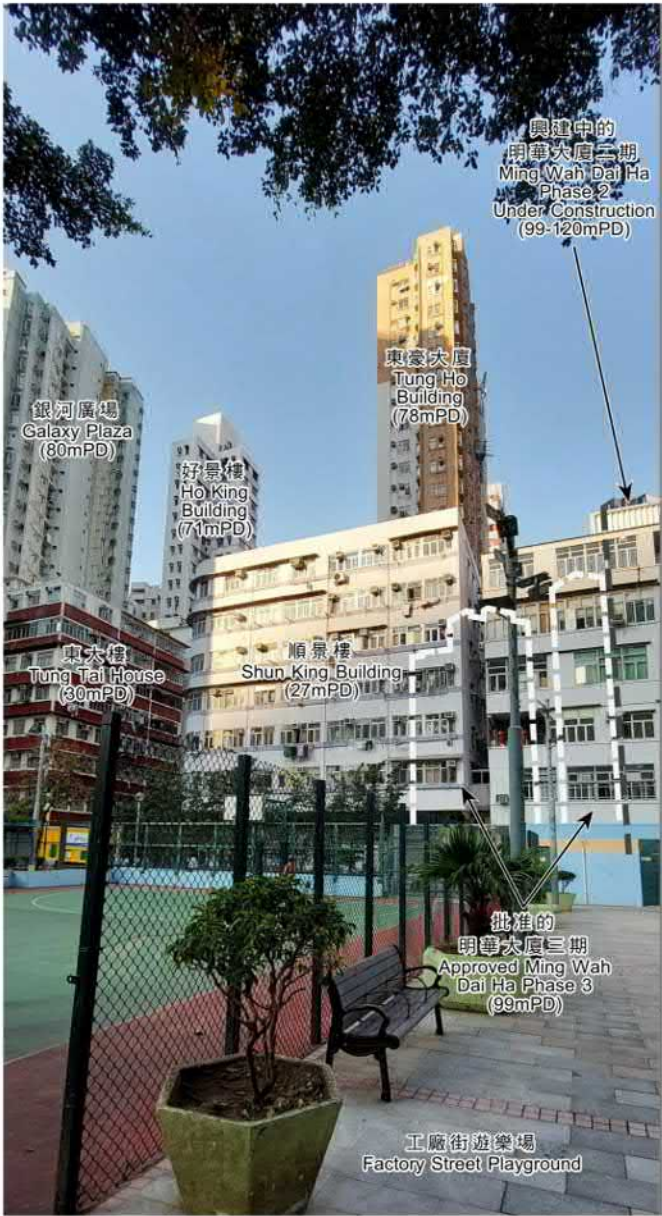
基線情況 BASELINE CONDITION
