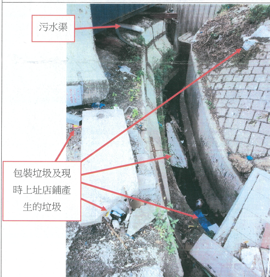
GV2：污水渠直接接駁到明渠及包裝垃圾及現時上址店鋪產生的垃圾
