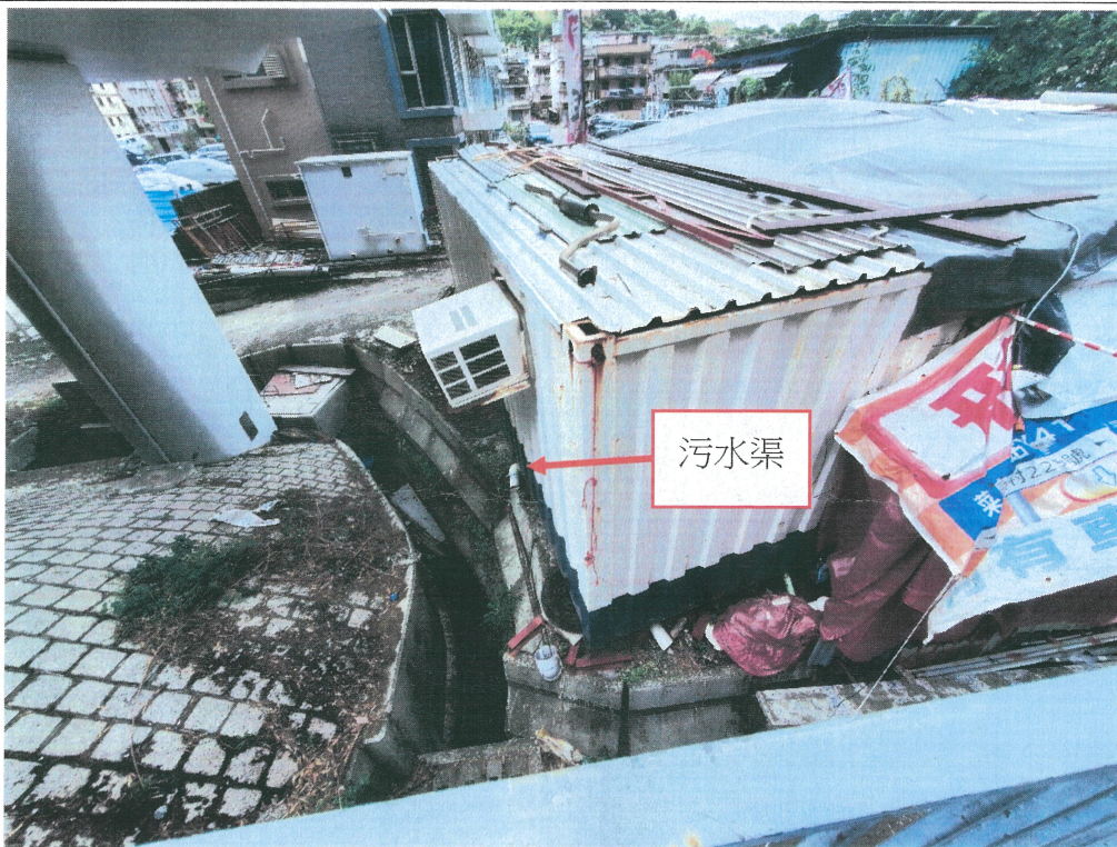
GV1：污水渠直接接駁到明渠
