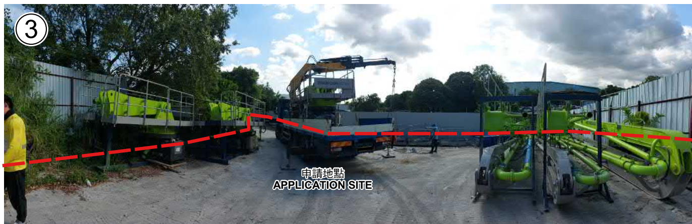
攝於2025年9月5日的實地照片 SITE PHOTO TAKEN ON 5.9.2025
