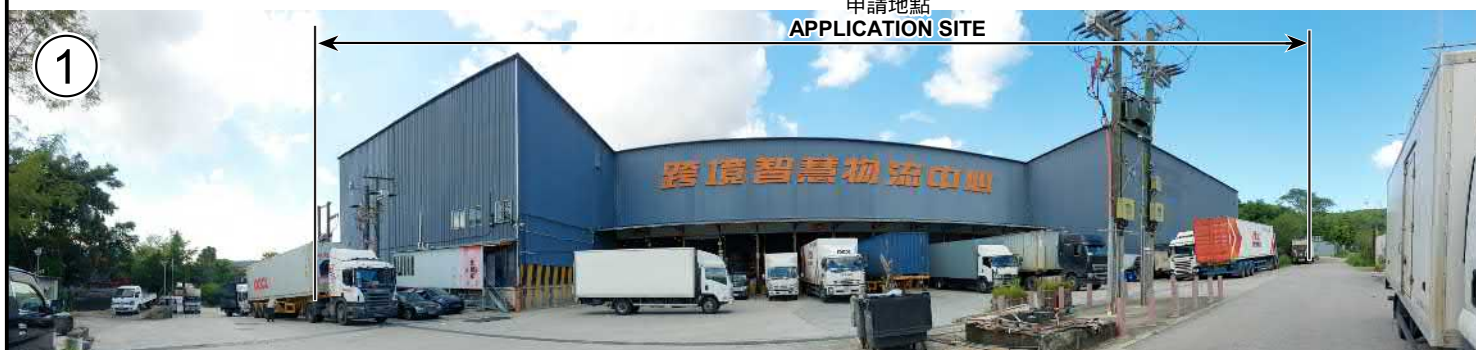
攝於2025年9月12日的實地照片 SITE PHOTO TAKEN ON 12.9.2025
