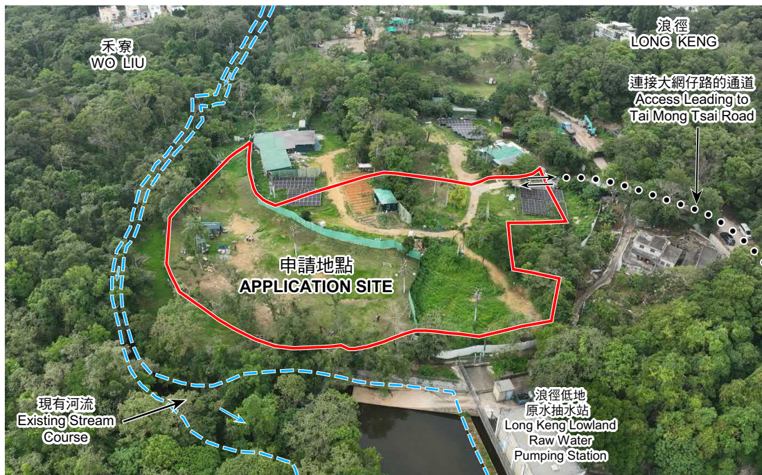
攝於2026年5月11日S17覆核申請期間的無人駕駛航拍照片 UNMANNED AERIAL VEHICLE (UAV) PHOTO TAKEN DURING S17 REVIEW APPLICATION ON 11.5.2026
