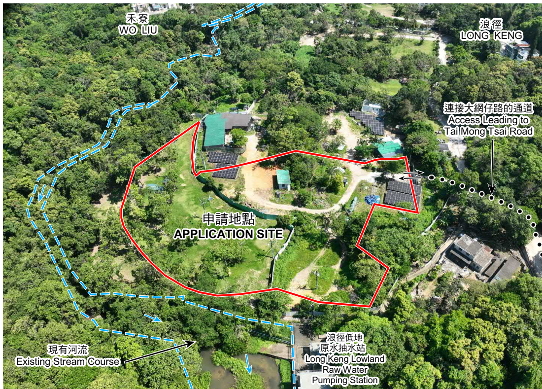
攝於2025年7月25日S16申請期間的無人駕駛航拍照片 UNMANNED AERIAL VEHICLE (UAV) PHOTO TAKEN DURING S16 APPLICATION ON 25.7.2025
