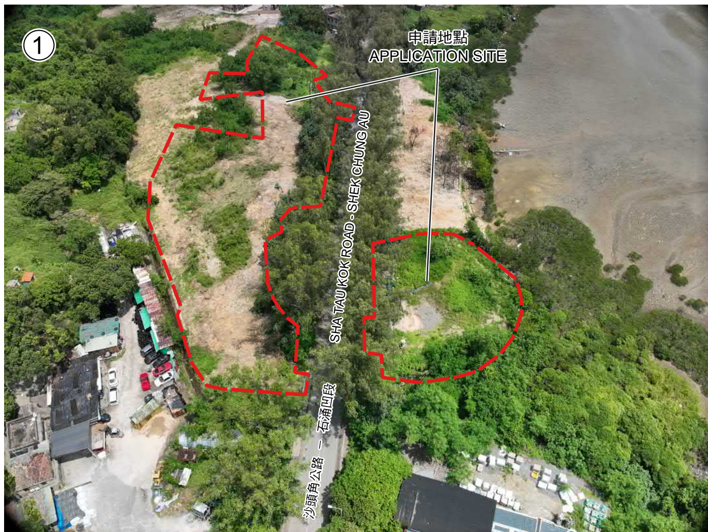
攝於2026年9月4日的實地照片 SITE PHOTO TAKEN ON 4.9.2026
