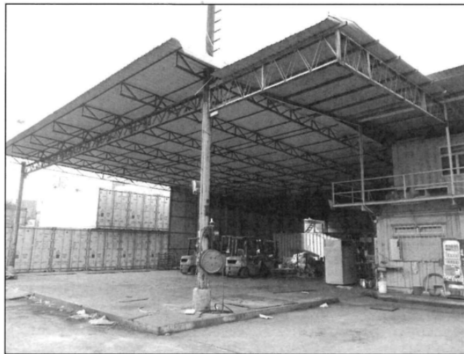
上蓋物 3以金屬搭建，部份屬三面開放的過貨涼棚。
