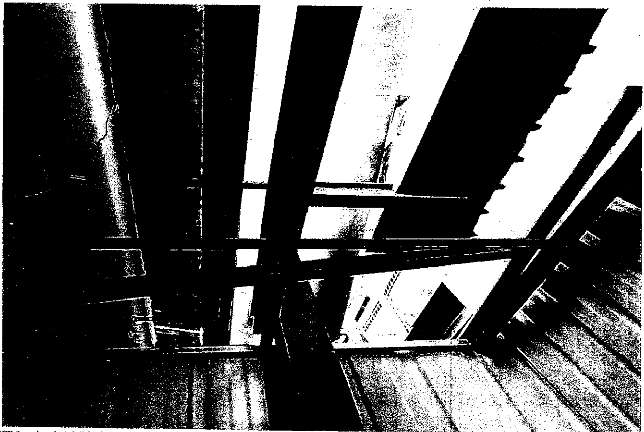
圖9: 在本社牆身上下都有鐵板封住，有鐵架直接安裝到本社牆身。
