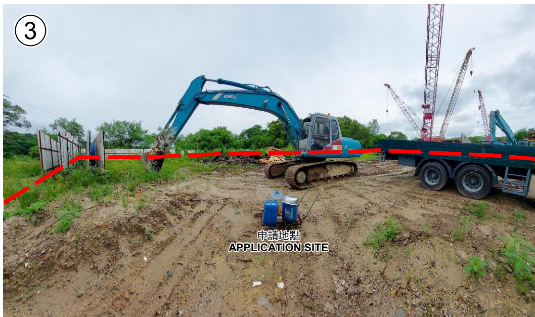
攝於2024年8月19日的實地照片 SITE PHOTO TAKEN ON 19.8.2024
