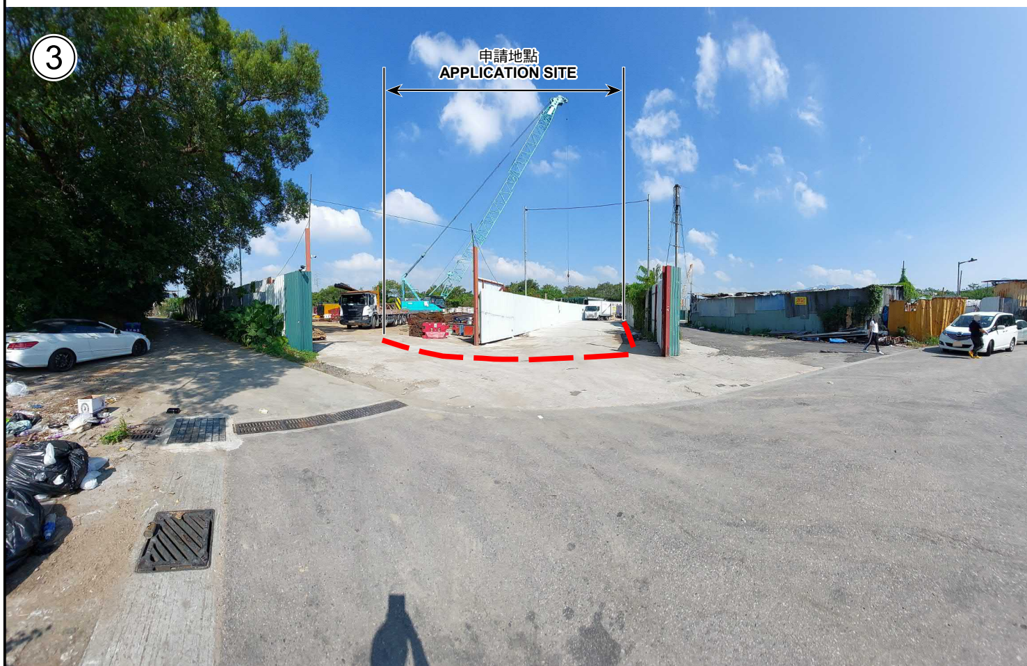
攝於2024年10月15日的實地照片 SITE PHOTO TAKEN ON 15.10.2024
