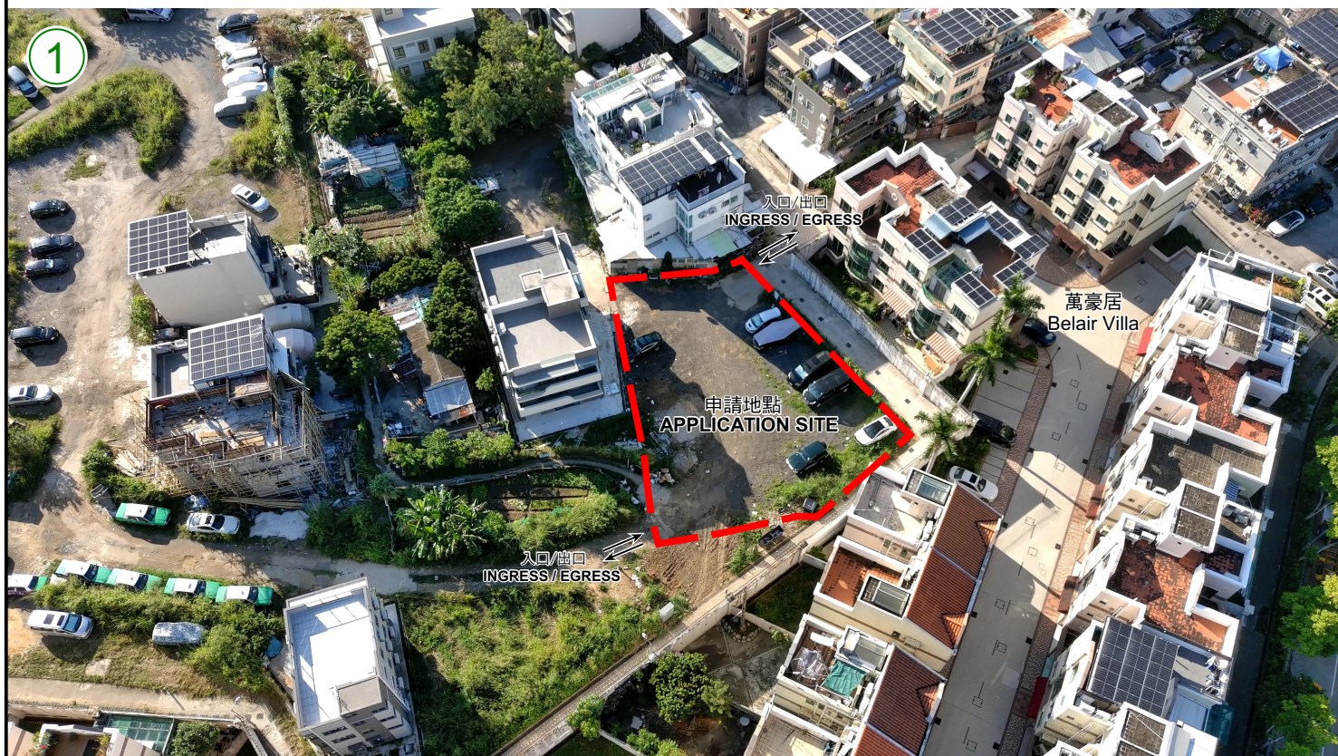
攝於2022年11月29日的無人駕駛航拍照片 UNMANNED AERIAL VEHICLE (UAV) PHOTO TAKEN ON 29.11.2022
