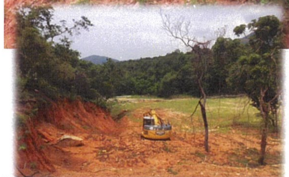
嚴重削坡，挖出的泥土可能用作平整土地之用，完全破壞原有地貌，亦做成山泥傾瀉的潛在危險。
