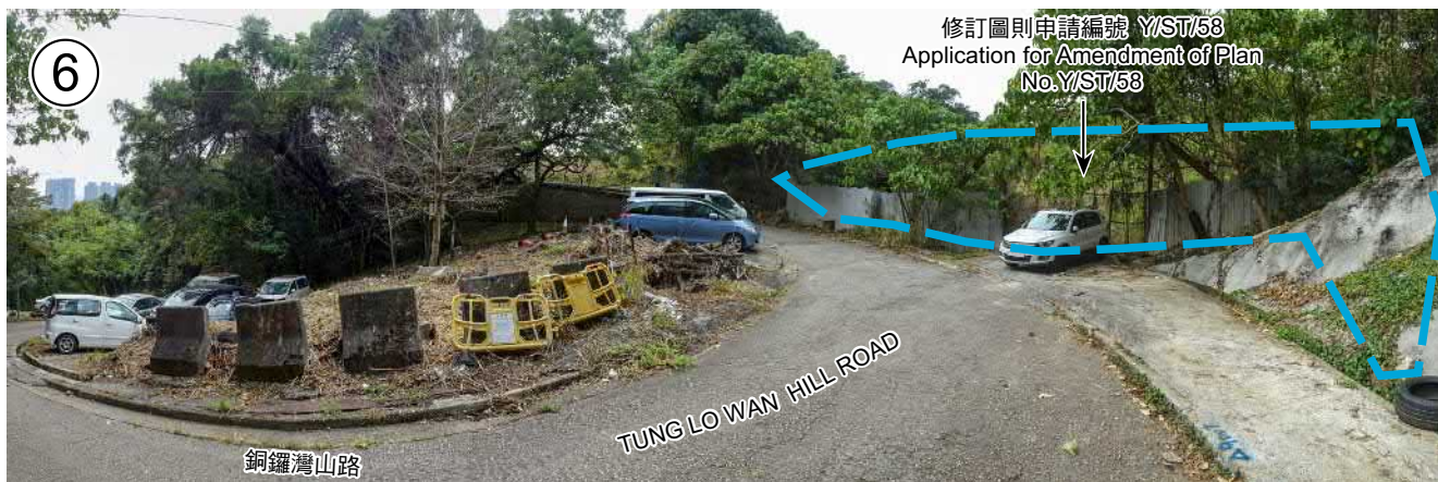
攝於2025年2月5日的實地照片 SITE PHOTO TAKEN ON 5.2.2025
