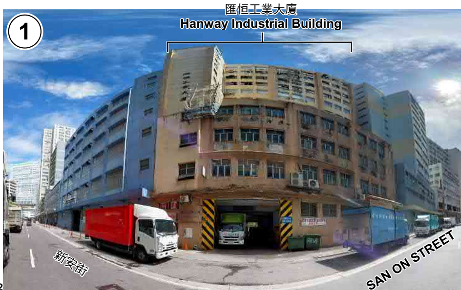
攝於2022年10月20日的實地照片 SITE PHOTO TAKEN ON 20.10.2022
