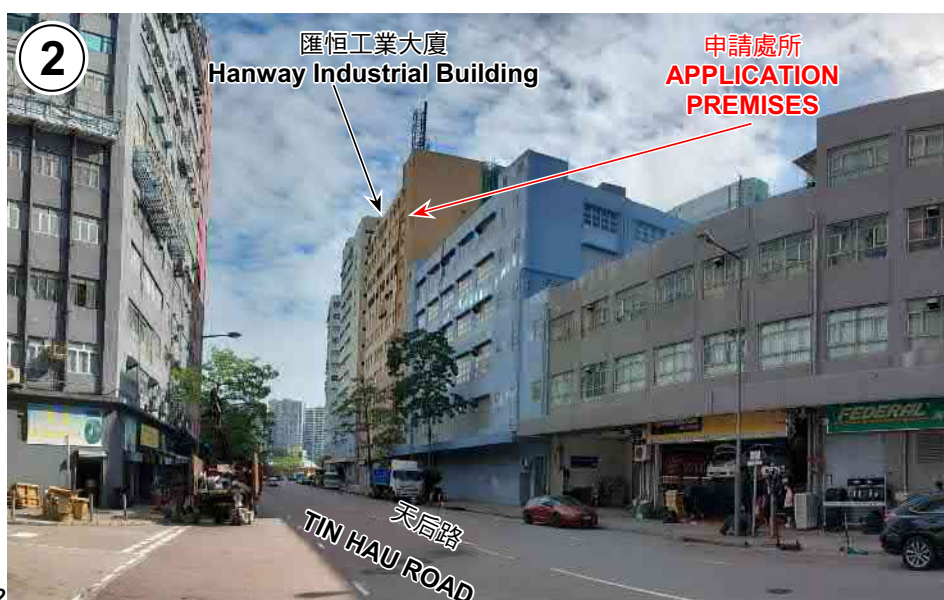
攝於2022年10月13日的實地照片 SITE PHOTO TAKEN ON 13.10.2022
