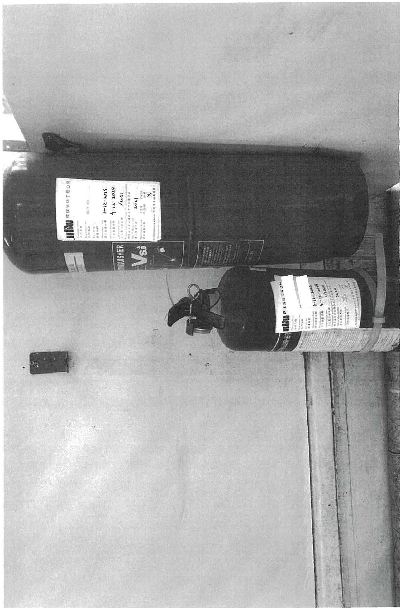
圖(1,2) 上層辦公室放置 1 個 9 公升 CO2 和 1 個 4kg Dry Power 滅火桶
