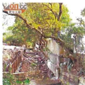
八鄉 竹坑村河旁大興土木，令香港
