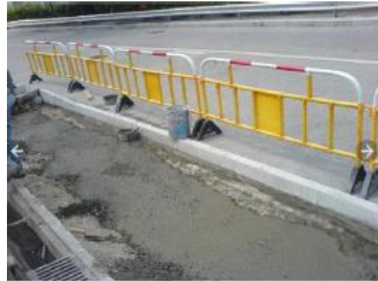
(d) Concrete paving
